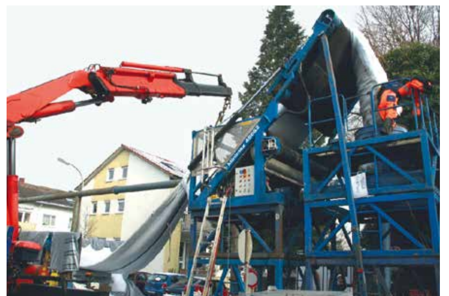
Schlauchliner beim Einzug in den Kanal, Überlinger Straße (2018)
