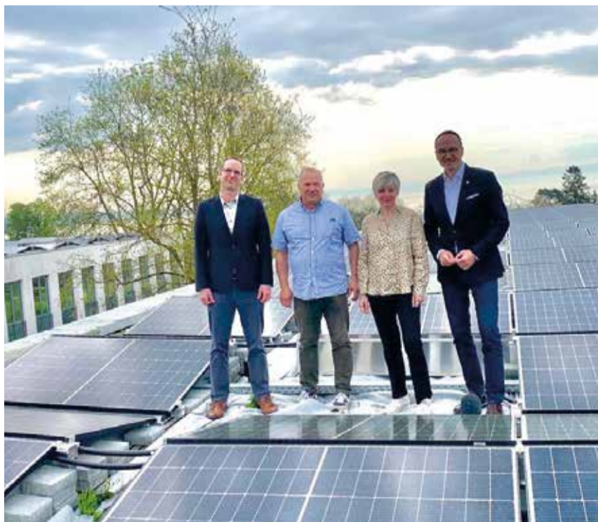
Blicken mit Stolz auf die neue PV-Anlage der Jugendherberge in Konstanz (v.l.n.r.): Joachim Plesch von Gorfion Green Energy GmbH, Leiter Arthur Striebel und Leiterin Sabine Striebel sowie OB Uli Burchardt
