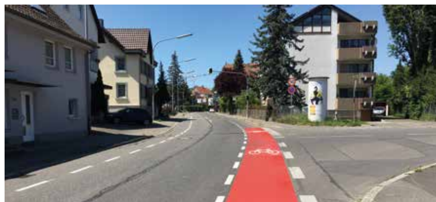
Farbmarkierung: Zur Verbesserung der Infrastruktur wurden in mehreren längeren Abschnitten Radschutzstreifen markiert.
