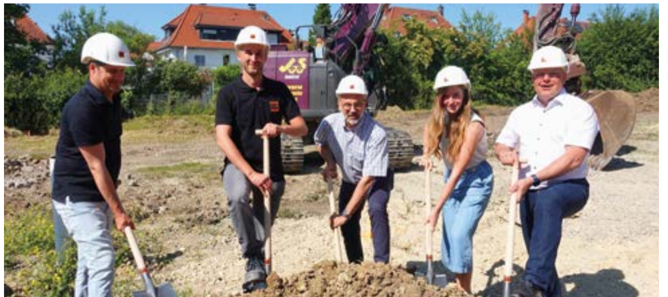
Startschuss für den Bau von fünf Wohnhäusern der Spitalstiftung: Am Spatenstich nahmen (v. l.) Jan Voswinkel (Projektleiter Architekturbüro Lanz+Schwager), Daniel Olbert (Bauleiter Fa. Wölfert und Goebel), Bürgermeister Dr. Andreas Osner, Melanie Hasselmann (techn. Leiterin der Spitalstiftung Konstanz) und Andreas Voß (Stiftungsdirektor) teil.
