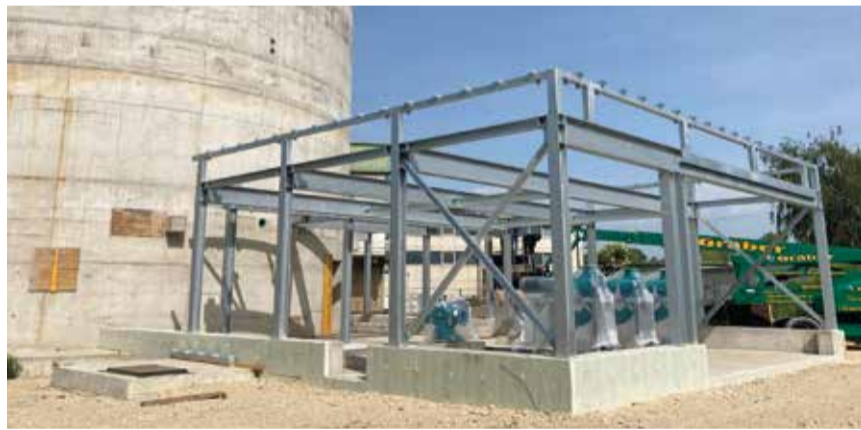
Dem Faulturm vorgelagert: das Technikgebäude, Mitte Mai noch als unverkleideter Stahlskelettbau
