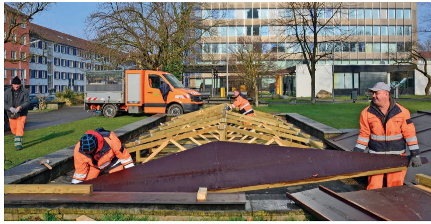
Das TBK-Team entfernt die aufwendige Brunnenabdeckung
