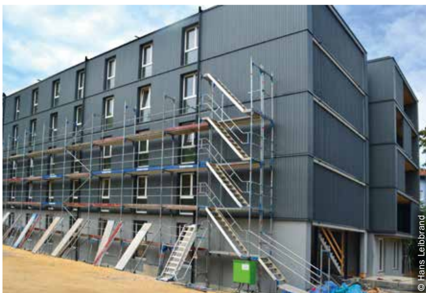
In der Sonnenbühlstraße wird seit August 2020 eine Anschlussunterbringung mit 63 Wohneinheiten in Holzmodulbauweise realisiert
