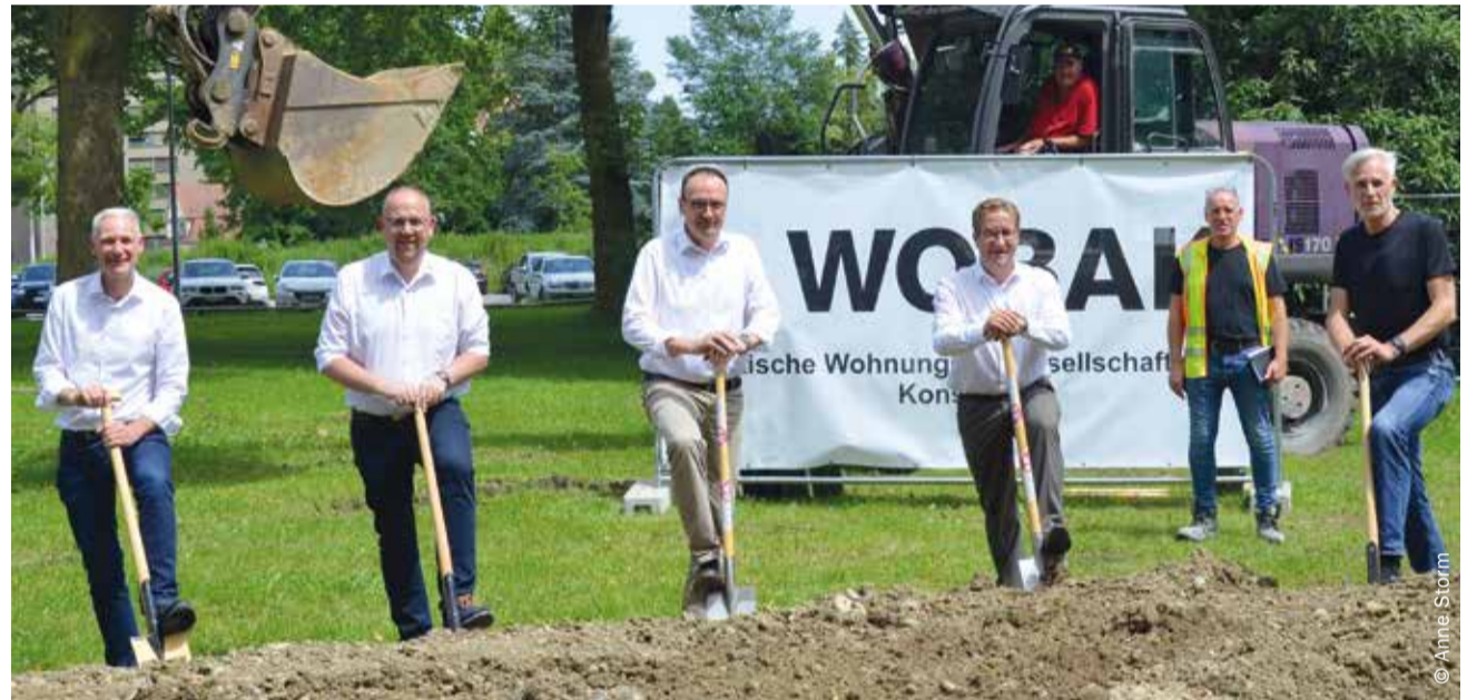
An der Luisenstraße entstehen in Holzelementbauweise 45 Wohneinheiten, die vorerst als Anschlussunterbringung für Geflüchtete genutzt werden sollen. Darüber freuen sich beim symbolischen ersten Spatenstich (v.l.n.r.): Karl Langensteiner-Schönborn (Baubürgermeister), Andreas Wiesler (Geschäftsführer Holzbau Bruno Kaiser), OB Uli Burchardt, Jens-Uwe Götsch (Geschäftsführer WOBAK) und Hannes Mayer (Projektleiter WOBAK).
