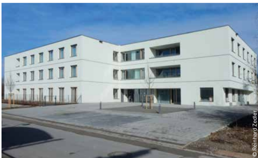
Das Pflegeheim Jungerhalde mit 60 Pflegeplätzen wurde im Dezember 2020 fertiggestellt und Anfang dieses Jahres an die AWO als Betreiberin übergeben.
