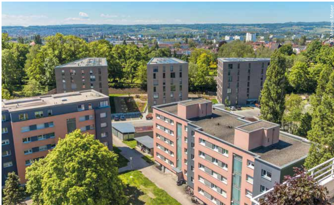
Über das Blockheizkraftwerk der Stadtwerke und das effiziente Wärmenetz am Pfeifferhölzle im Untergrund werden umliegend insgesamt über 600 Wohnungen versorgt.
