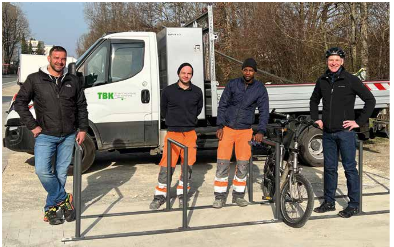
Installation der Radabstellanlagen an der Bushaltestelle Schwaketenbad. Ab Sommer 2022 ist hier eine neue konrad Lastenrad Station zu finden.
