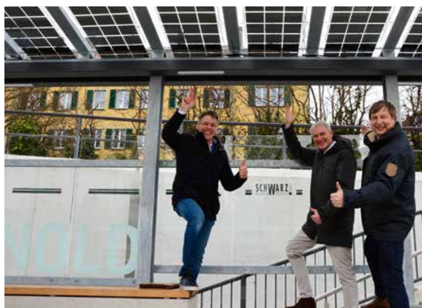
Eine aufs Dach: Die neugestaltete Bushaltestelle am Sternenplatz wurde nun mit Photovoltaik ausgestattet. Das verglaste Dach der Warthalle wurde auf Initiative der Stadt Konstanz mit Solarmodulen bestückt, die durch einen Solartower ergänzt werden. Regenerative Energieerzeugung durch PV-Anlagen ist an vielen Stellen möglich und viele kleine Maßnahmen leisten einen wichtigen Beitrag zum Klimaschutz – das finden auch Christoph Schwarz, Geschäftsführer von Schwarz Außenwerbung GmbH, Bürgermeister Karl Langensteiner-Schönborn sowie Stadtrat Dr. Jürgen Ruff (v.l.) von der SPD-Fraktion, die bereits 2019 für die Idee geworben hatte, Bushaltestellen mit Photovoltaik auszustatten.
