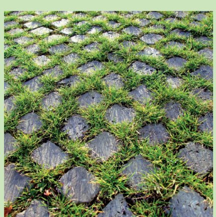
PFLASTER MIT RASENFUGE
