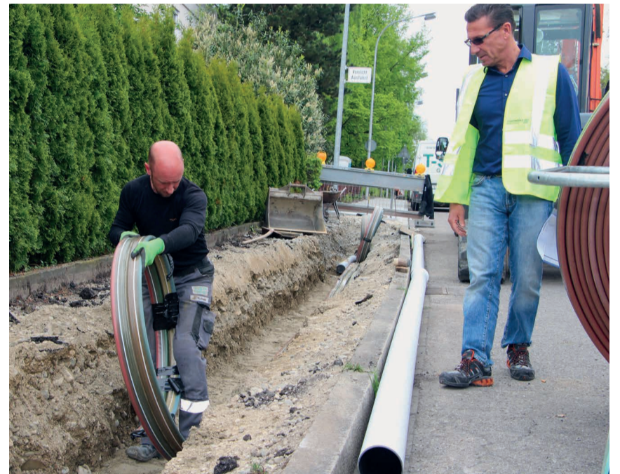
In die Gräben werden Leerrohre, auch „Flatliner“ genannt, verlegt. Sie werden in Sand eingebettet und mit einer Abdeckplatte versehen, damit bei zukünftigen Tiefbauarbeiten keine versehentlichen Beschädigungen auftreten können. In die Leerrohre werden später Glasfaserkabel eingeblasen, also mit hohem Druck hineingepresst.
