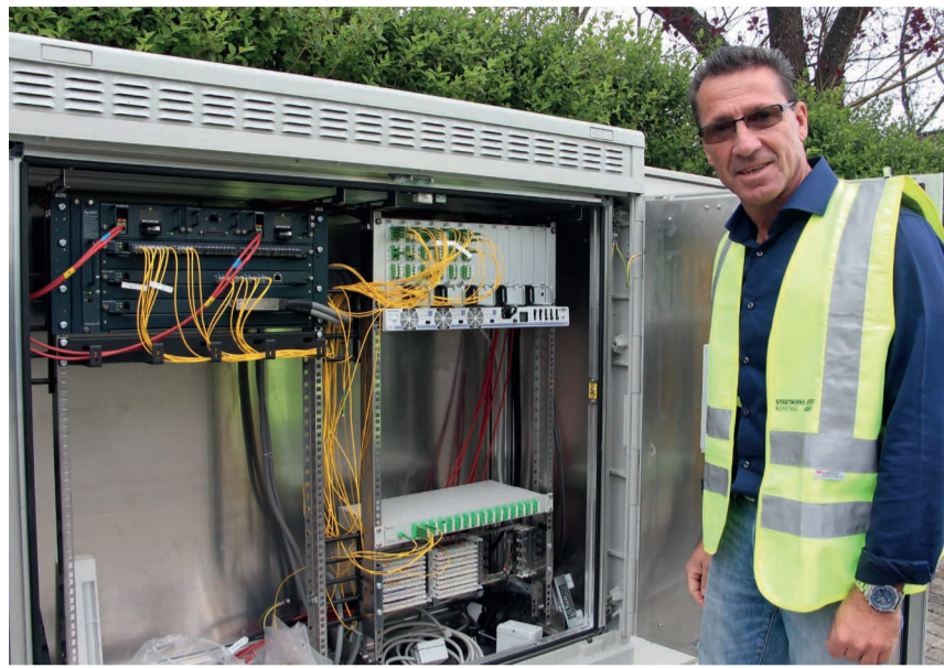
Gerhard Philipp, Baustellenkoordinator im Geschäftsbereich Telekommunikation der Stadtwerke Konstanz, zeigt einen Verteilerkasten. Die Kästen sind nötig, damit ein Gebiet überhaupt an die Datenautobahn angeschlossen werden kann.
