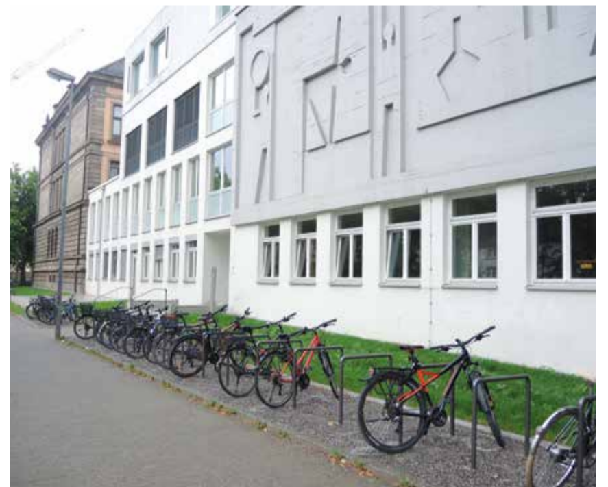
270 neue Fahrradstellplätze am Humboldt-Gymnasium: Erfreulicherweise fahren immer mehr Konstanzner Schüler mit dem Fahrrad zur Schule. In den Sommermonaten sind dies häufig bis zu 2/3 der Schüler. Die neuen Abstellanlagen am Humboldt-Gymnasium sind der erste Bauabschnitt einer schrittweisen Sanierung des gesamten Schulhofes. Die Kosten von ca. 330.000 € werden im Rahmen der Nationalen Klimaschutzinitiative gefördert vom Bundesministerium für Umwelt, Naturschutz und nukleare Sicherheit aufgrund eines Beschlusses des Deutschen Bundestages.
