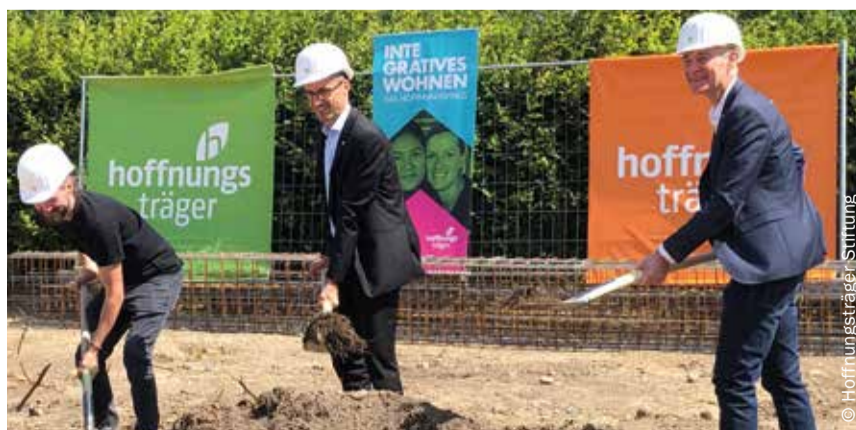
Spatenstich für die Hoffnungshäuser mit Thorsten Blatter (andOFFICE), Marcus Witzke (Vorstand Hoffnungsträger Stiftung) und Bürgermeister Karl Langensteiner-Schönborn.
