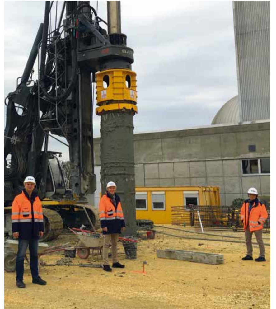
Mirco Ebeling, Karl Langensteiner-Schönborn und Ulrike Hertig vor dem Bohrpfahlgerät
