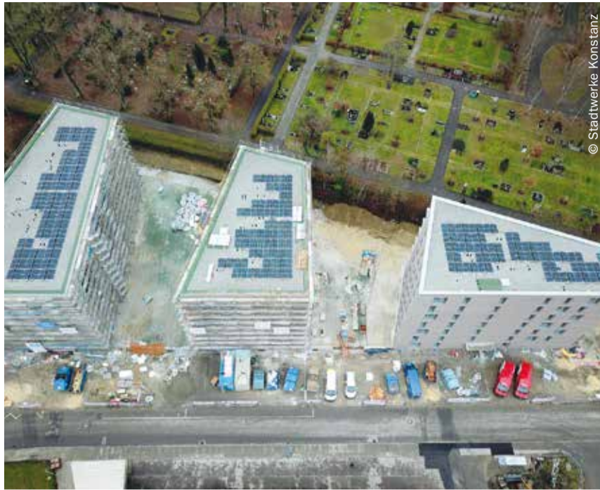
Die Dächer der Neubauten am Pfeiferhölzle wurden mit PV-Anlagen ausgerüstet.
