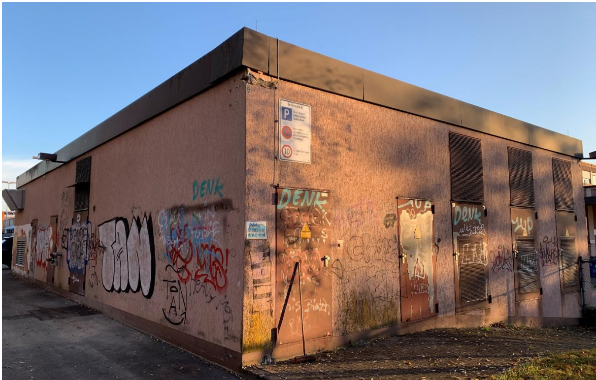
Abbildung 43: Energiezentrale auf dem Gelände Max-Stromeyer-Straße 160
