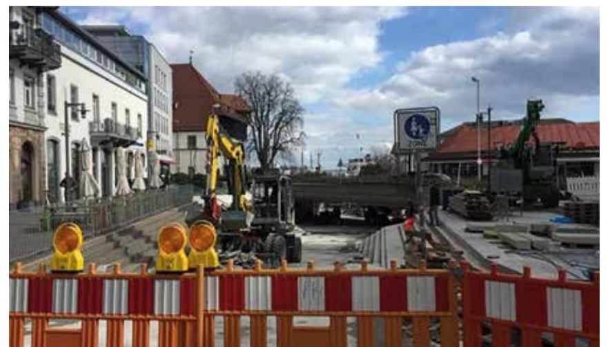
Baustelle an der Marktstätte-Unterführung
