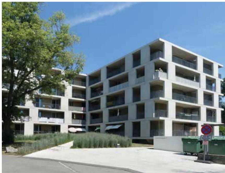
Der mit dem Bauherrenpreis ausgezeichnete Neubau des Wohnheims
