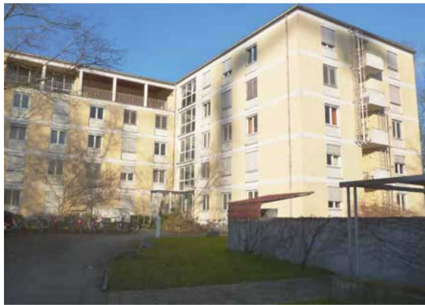
Das alte Wohnheim in der Luisenstraße
