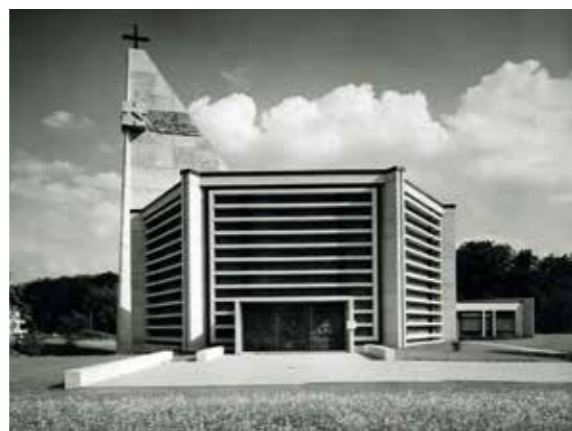
Maria-Hilf-Kirche erbaut 1967 Architektur: Franz Hitzel; Foto: Heinz Kabus, mit freundlicher Genehmigung Frank Kabus
