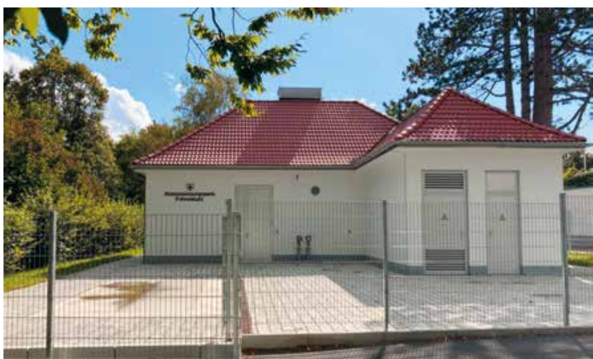
Das frisch sanierte Abwasserpumpwerk Fohrenbühl am Eingang zum Hörlepark
