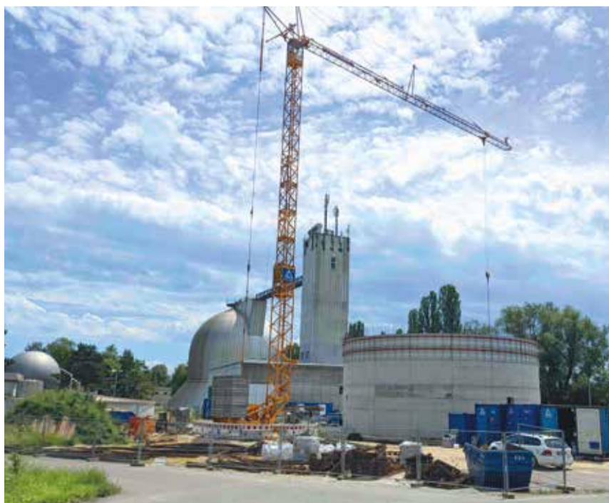
Der Rohbau des ersten Faulturms ist bald abgeschlossen, die Baustelle im Juni 2021.
