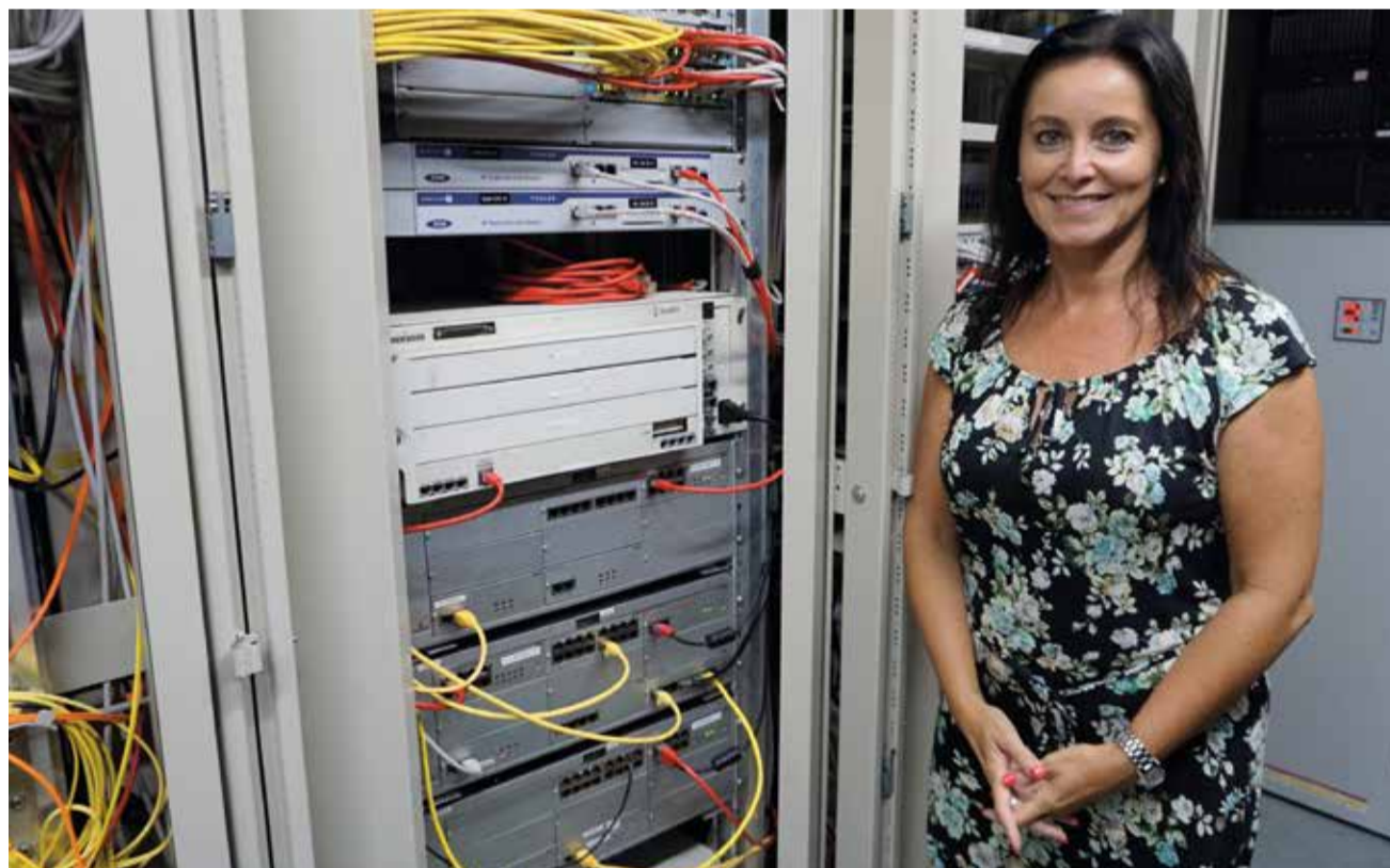
Der Serverraum, in dem sich Yvonne Böhne befindet, ist das Herzstück der städtischen Telefonanlage.
