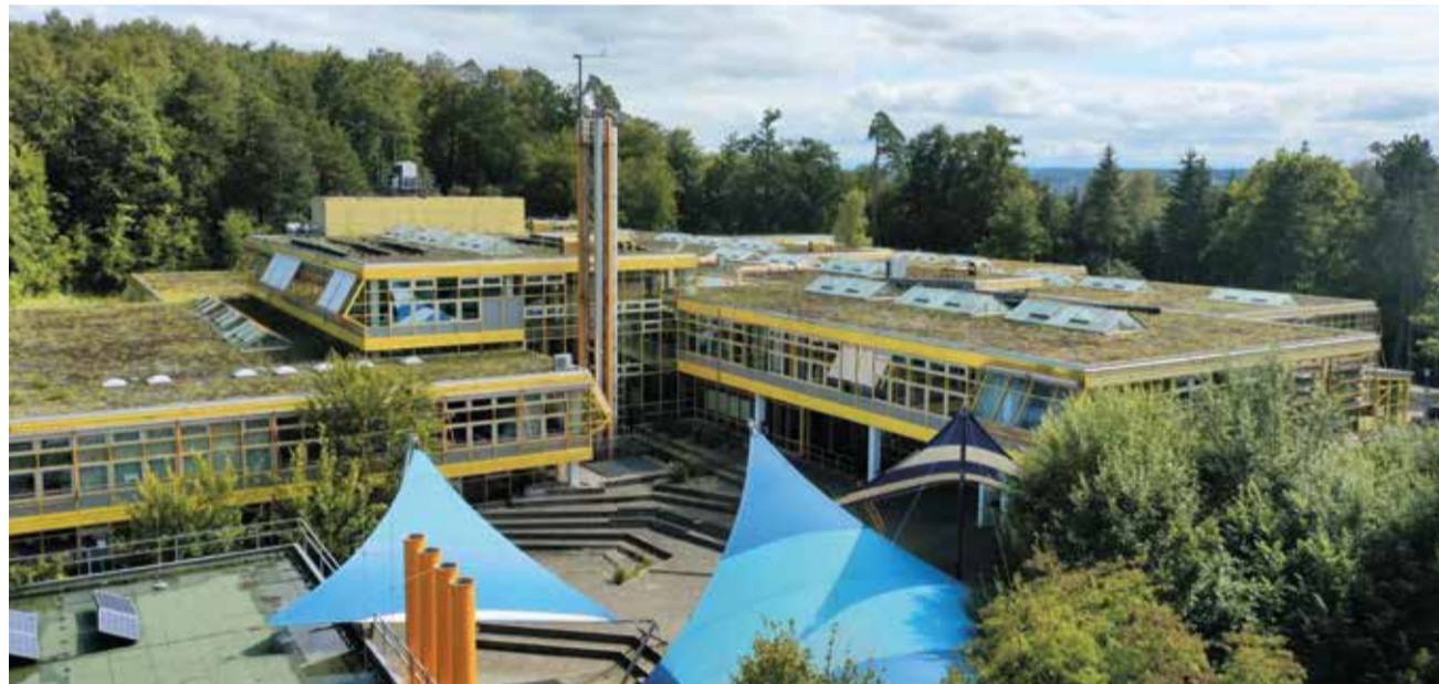
Im Herbst werden die ersten Dachflächen der Geschwister-Scholl-Schule saniert.
