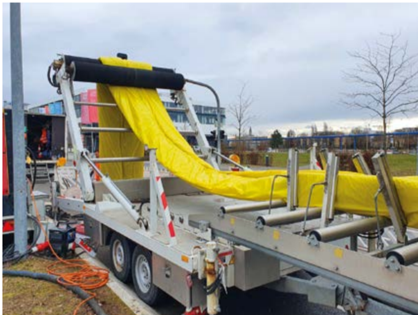
Der gefaltete und noch verpackte Schlauchliner vor dem Einbau in den Kanal
