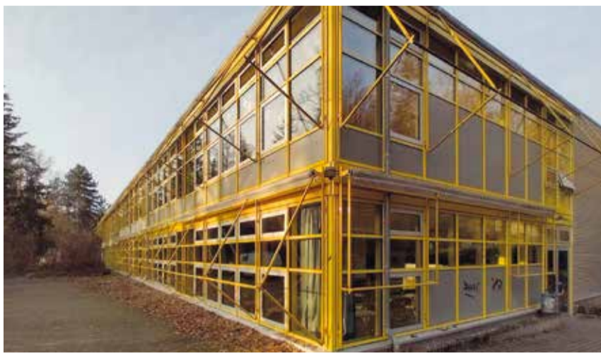
Die Geschwister-Scholl-Schule (GSS) wird aktuell generalsaniert. Weitere städtische Gebäude werden nun folgen.
