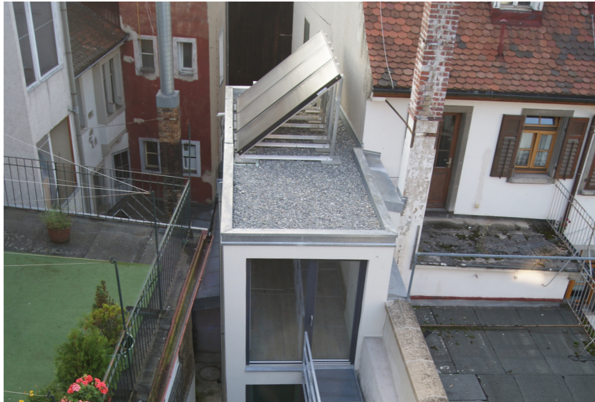
Abb. 51: Solarthermie-Anlage auf modernem Nebengebäude des Hauses Wessenbergstraße 37 (Fallgruppe 5), 2011
