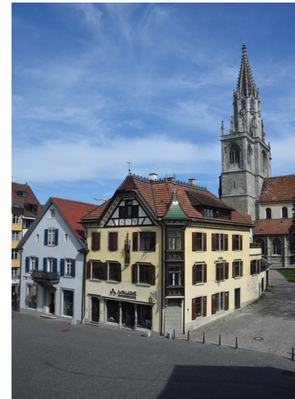
Abb. 44 (oben rechts): Bauzeitliche Elemente am „Deutschen Haus“: Biberschwanzdeckung und SchlepPGAube mit zugehöriger Entwässerung, 2024
