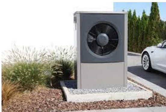
Beispiel eines Außengerätes einer Luftwärmepumpe
