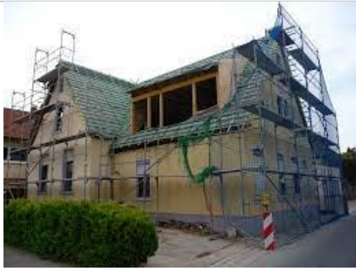
Gebäude während der Gebäudesanierung
