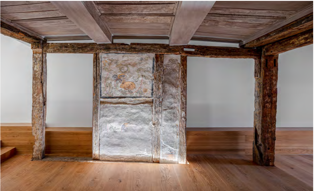
Das sanierte „Gasthaus Anker“, heute jüdisches Gemeindezentrum
