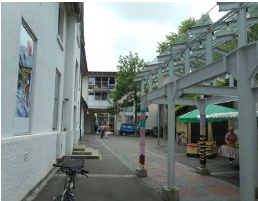
Bestand vor Umbaumaßnahme Franz-Knapp-Passage
