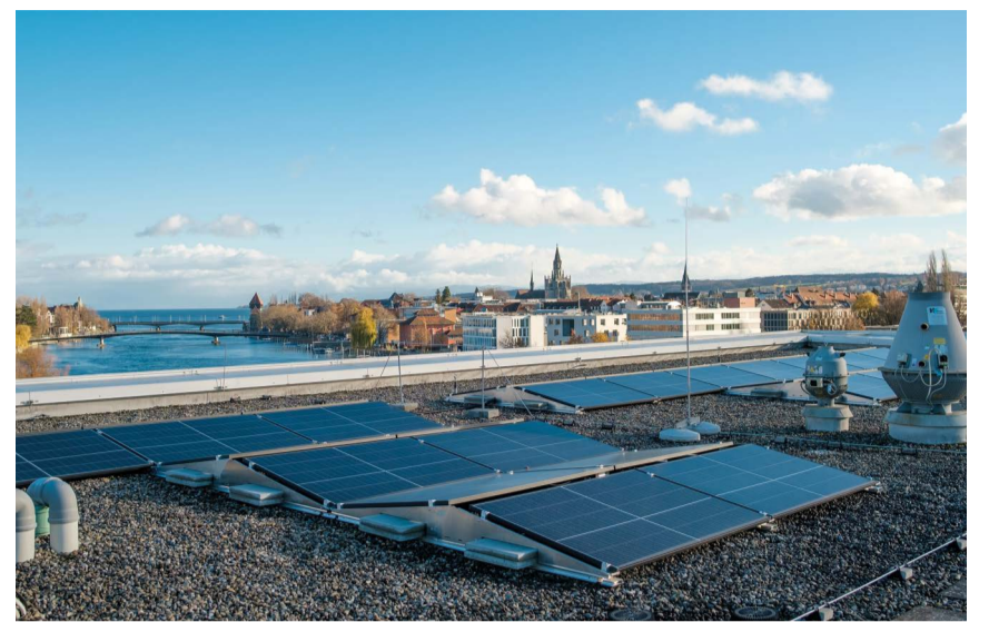
Die zweite Photovoltaikanlage läuft seit Oktober 2022 – ergänzend zu der bereits vorhandenen Anlage – auf dem Dach des Bodenseeforums sowie der IHK Hochrhein Bodensee. Die jährliche zusätzliche Stromproduktion wird auf ca. 96.701 kWh geschätzt.
