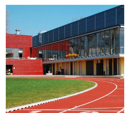
Der Außenbereich der Schänzlehalle bleibt während der Sanierungsarbeiten im Gebäude nutzbar.
