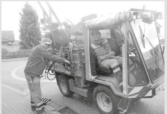
Die Bauhofkollegen Michael Rößler (l.) und Marc Bachmann (r.) bei der Säuberung der Sinkkästen
