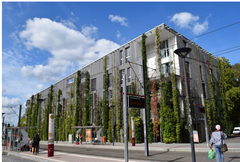
Abbildung 52: Fassadenbegrünung mit Rankhilfe (BuGG, o.J.)
