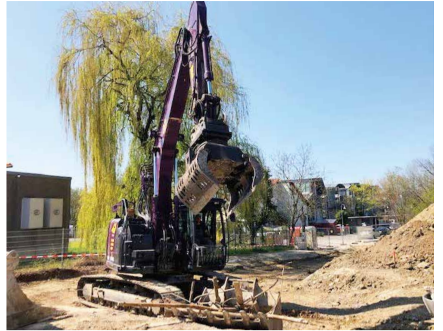
Die Baustelleneinrichtung an der Jungerhalde hat begonnen.
