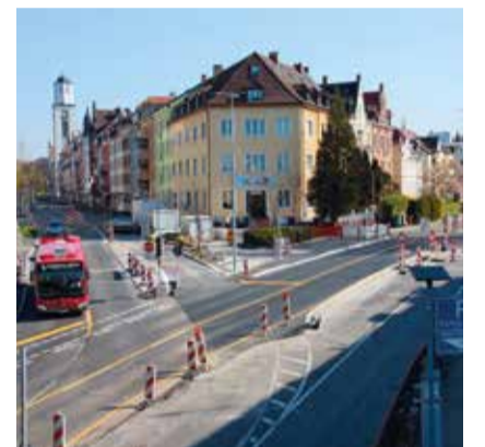
Die Sanierung des Sternenplatzes
