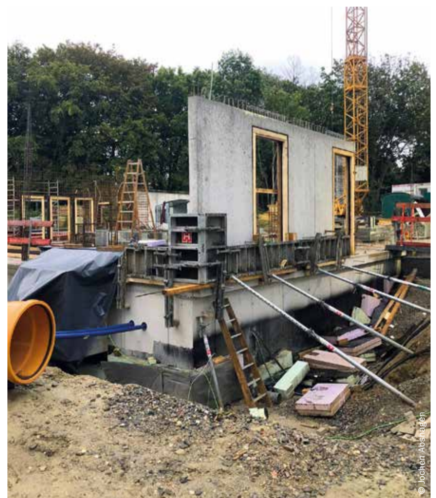
Kita Jungerhalde: Auf der Baustelle der Kita Jungerhalde ist inzwischen das Untergeschoss fertiggestellt, auch die Bodenplatte des Erdgeschosses ist erstellt. Aktuell werden die Wände im EG geschalt und betoniert. Die Fertigstellung ist für Anfang 2022 geplant.
