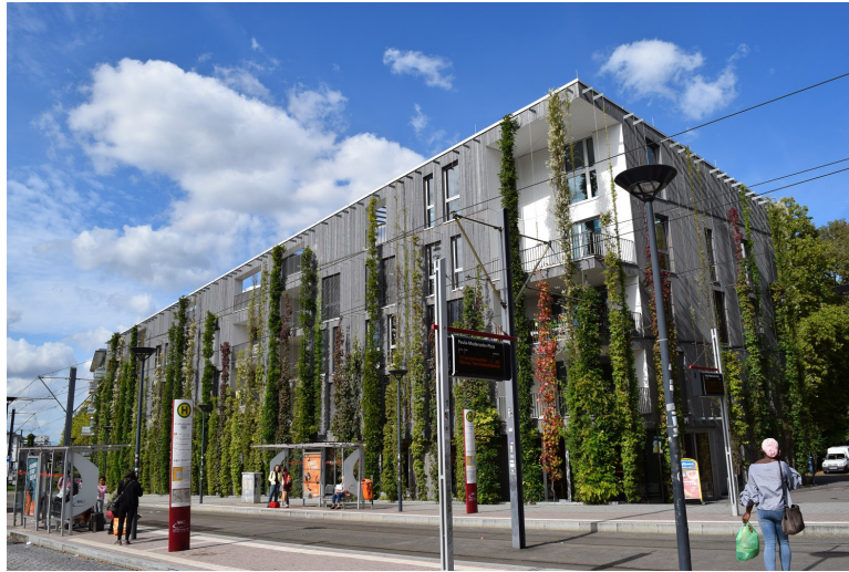
Abbildung 52: Fassadenbegrünung mit Rankhilfe (BuGG, o.J.)
